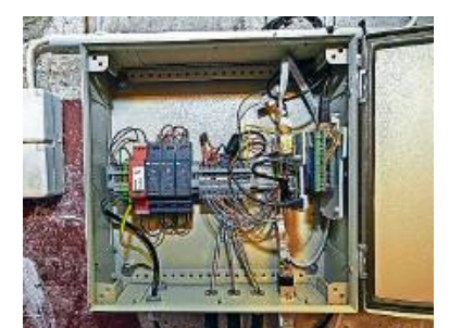
Das Herzstück: Die Rechner werten die Daten aus und leiten sie auch ins Internet weiter.
